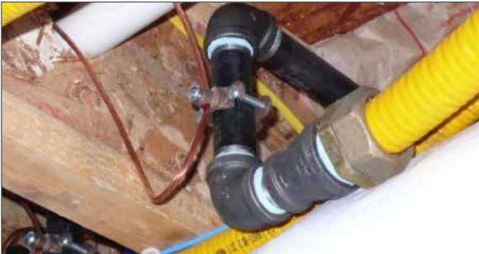
Conexión equipotencial de tubería CSST de gas combustible
