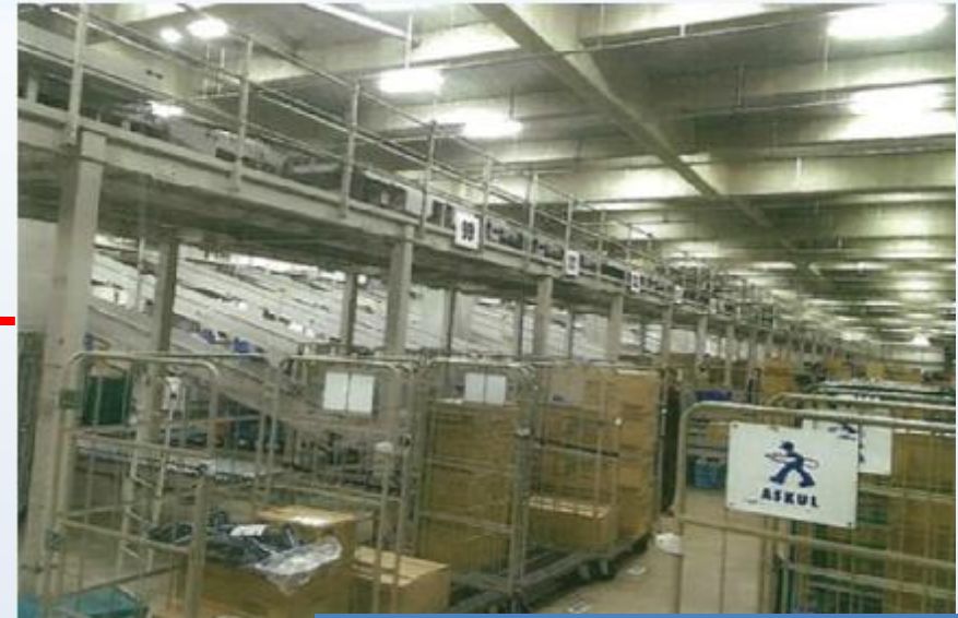
積み込みスペースの様子(②の付近)
